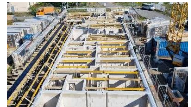
Casa Colorida – im Bau
