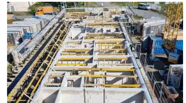
Casa Colorida – im Bau
