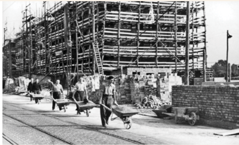
Eigenleistungen beim Bau d. ersten Häuser der AWG, Berlin Köpenick
