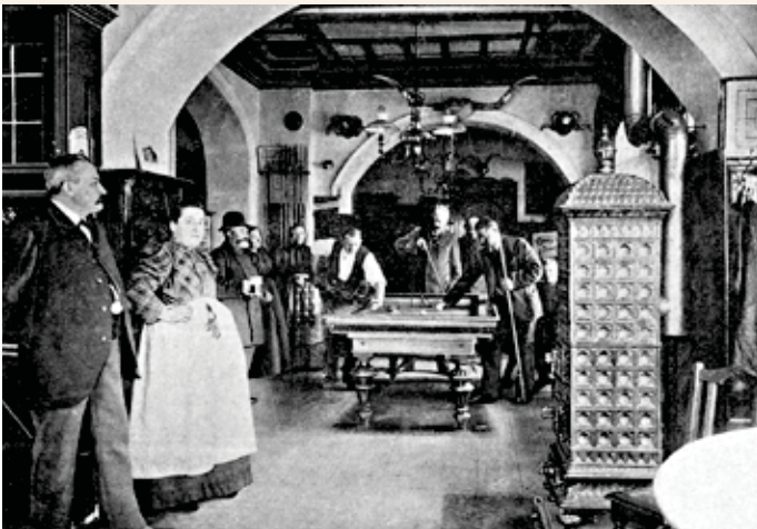
Wirtshaus des Berliner Spar- und Bauvereins in Friedrichshain
